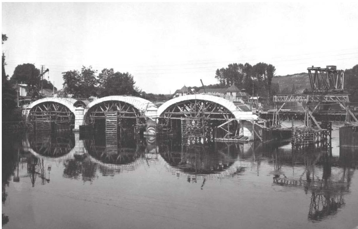
Reconstruction du pont : battage des palplanches pour les fondations des piles.
