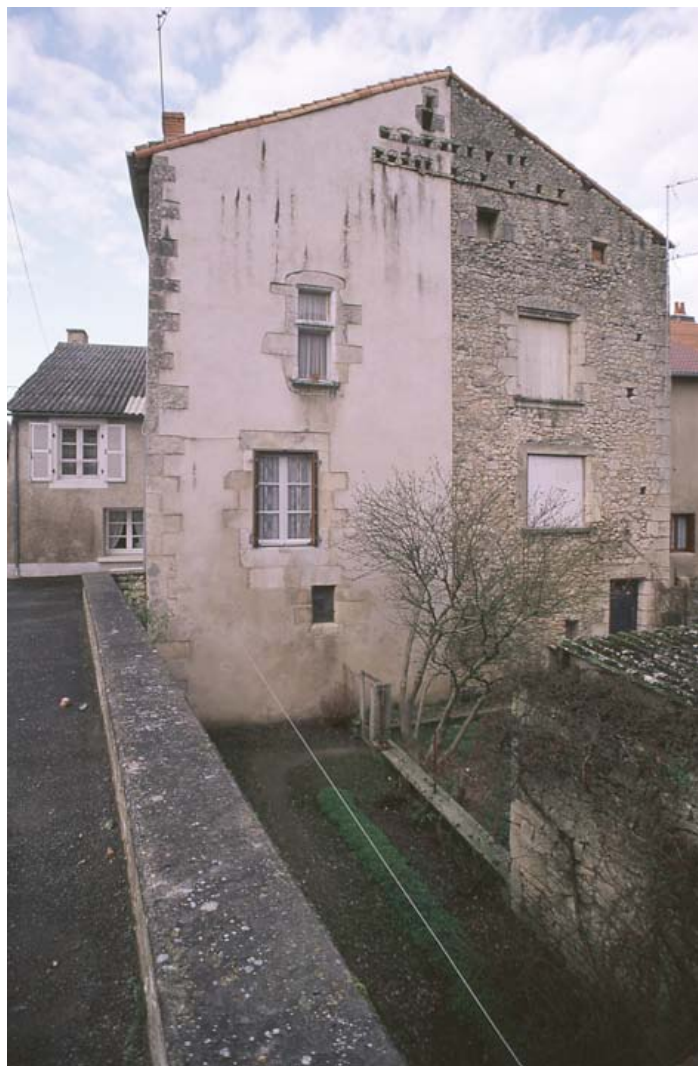
Maison ancienne 12, rue de l'Ancien Pont, Façade Sud.
