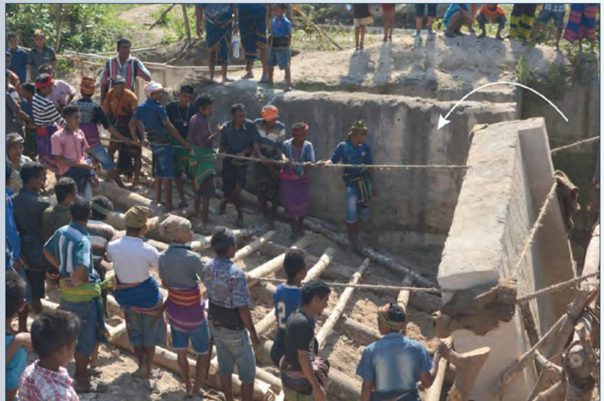
Extraction de la dalle de couverture, premiers mouvements de tirage et positionnement sur la rampe en bois
