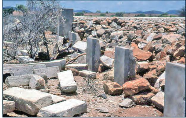
**Fig. 8** – Construction d'un tombeau Tandroy près d'Andalatanosy. Les orthostates du mur sont en place et le maçon façonne les blocs horizontaux entre eux. Pour chaque mur construit, il a reçu deux bovins (Cliché : M. Parker Pearson).
